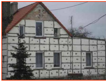
Fot. 11÷12 Przykłady nieprofesjonalnego wykonawstwa docieplenia
