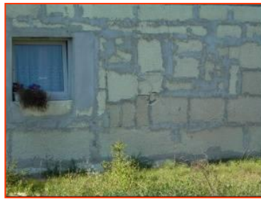
Fot. 11÷12 Przykłady nieprofesjonalnego wykonawstwa docieplenia
