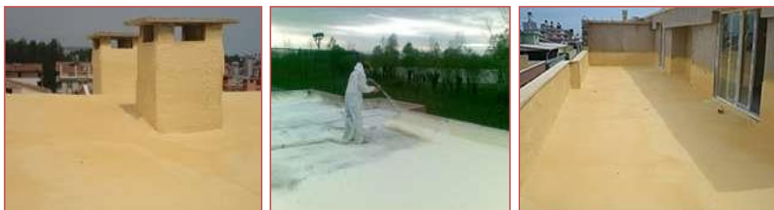
Fot. 2÷4 Metoda natryskowa docieplenia stropodachów pełnych
